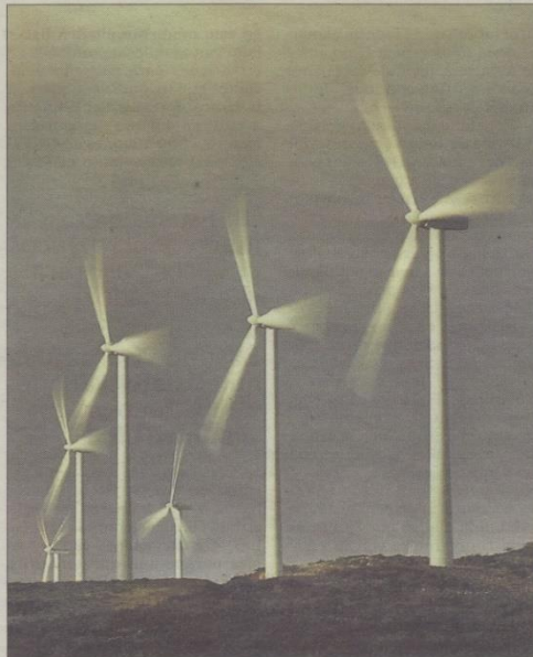
Parque eólico en Bande (Ourense). / NACHO GÓMEZ
